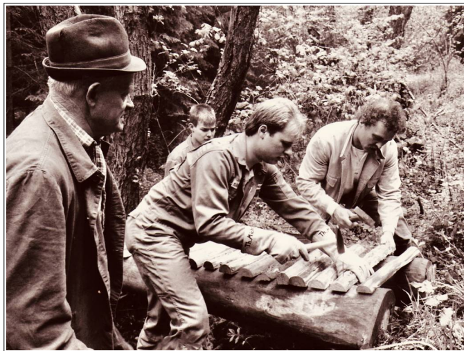
Brückenbau unter Anleitung von Kurt Knebel
