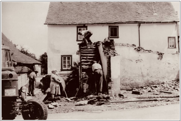
Abriss altes Rathaus 1966
