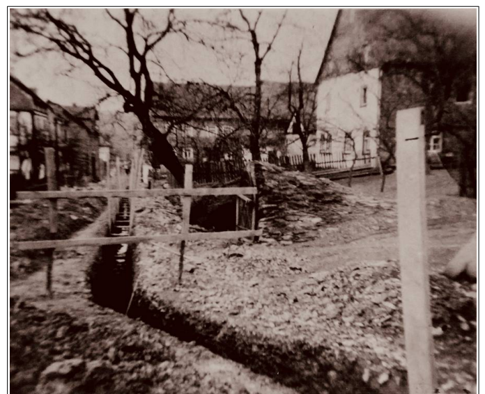
Bau von Wasserleitung und Kanalisation
