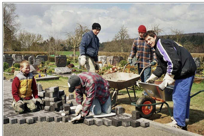
Pflasterarbeiten am dem Friedhof 2005
